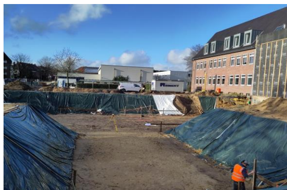
Blick in die aktuelle Baustelle
